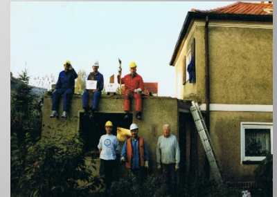
LWF – Lässt Wände Fallen - Abrissarbeiten bei Kern' s
